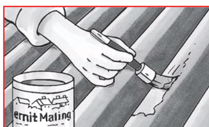
9 Pletmal småskader i farvelaget.
